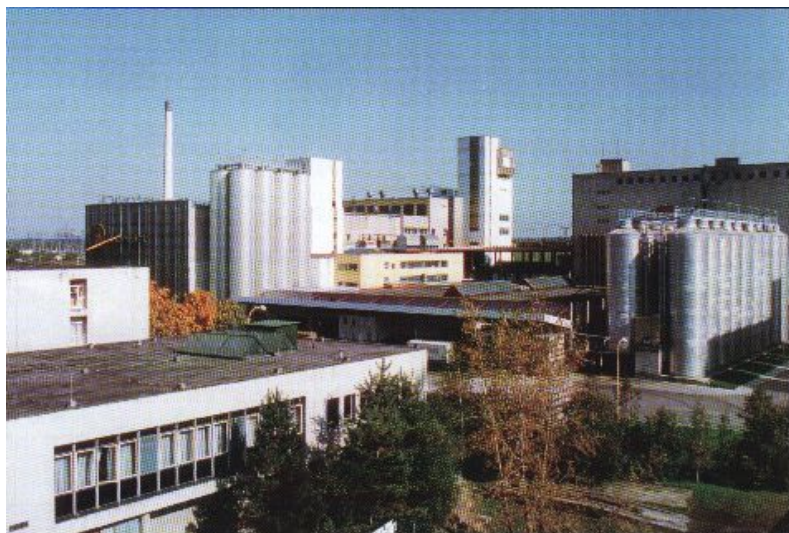
Obr. 10 - Venkovní instalace cylindrokónických tanků v pivovaru Radegast Nošovice
